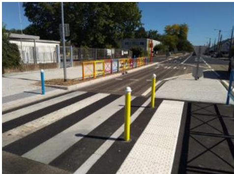
Passage piétons sécurisé (dispositif d'écocomobilité scolaire, Nantes Métropole)
