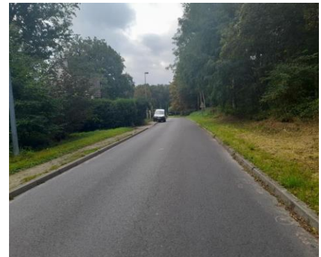
Rue du Bois d'Azier (voie large)
