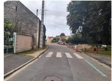
Rue de la Garenne : la zone de rencontre n'est pas clairement indiquée
